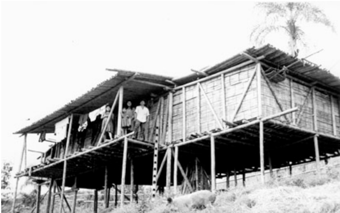
Foto 30: Casa toda de guadua, construida recientemente
